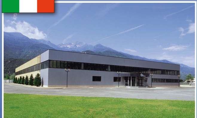
AUTOBLOK Werk in Caprie-Torino
