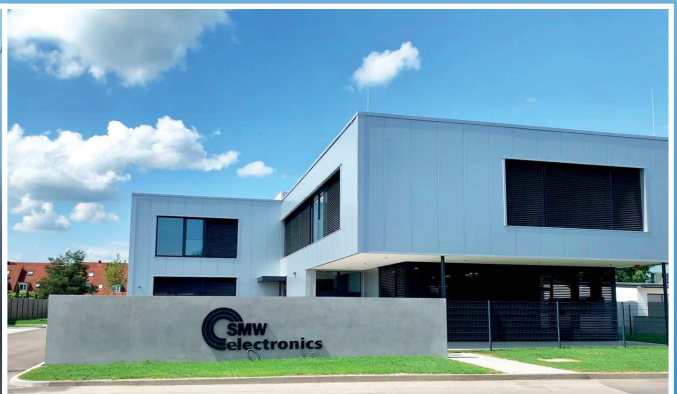
SMW-electronics Werk Meckenbeuren Entwicklung | Fertigung | Vertrieb | Service | Support
